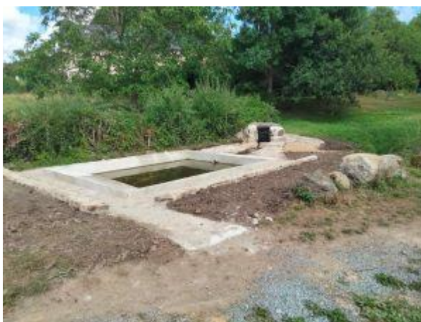
Fontaine-lavoir Le Fas (2025) ci-dessous
