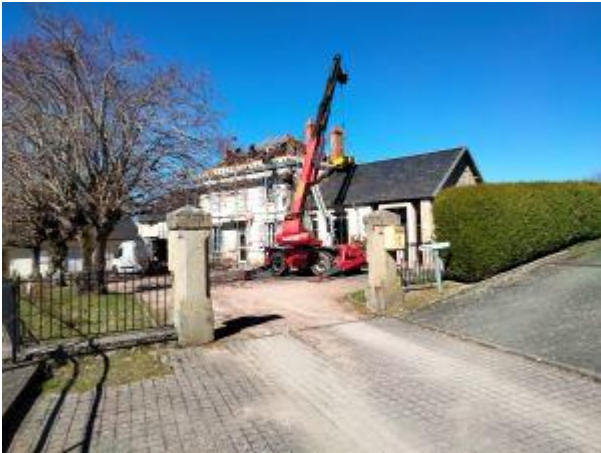
Dépose et pose en cours des couvertures
